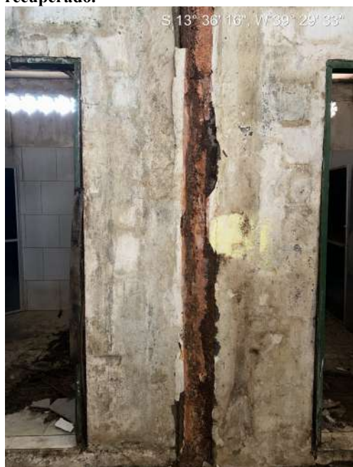
Figura 15 - Pilar cobertura a ser recuperado.
