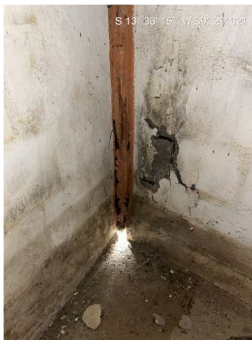
Figura 14 - Pilar da cobertura a ser recuperado.
