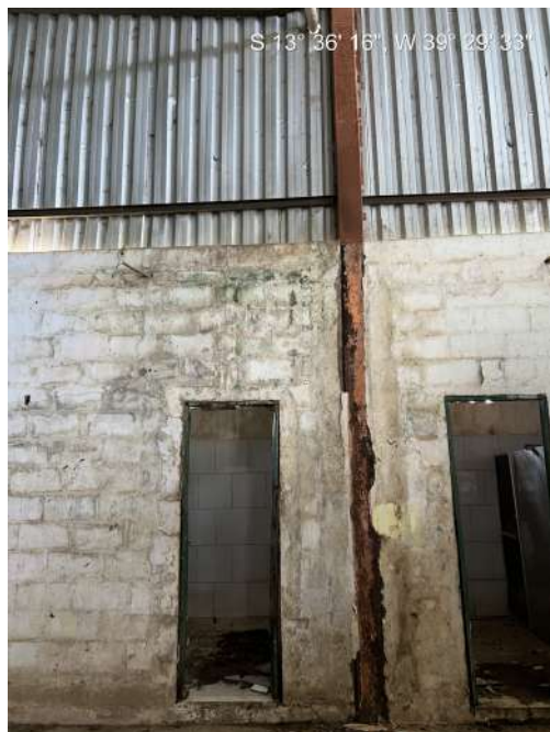
Figura 12 - Cobertura a ser recuperada e portas do banheiro que serão fechadas com alvenaria.
